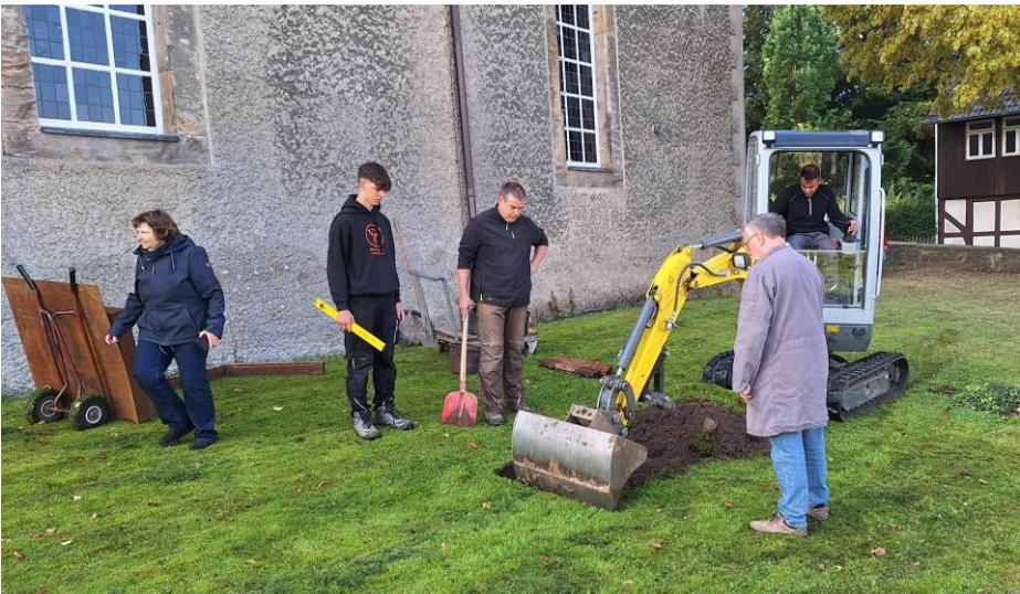
Die Grube für die Glockenform wird ausgehoben
