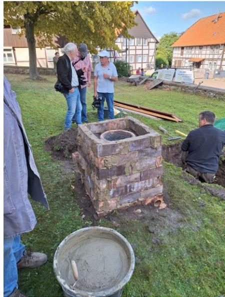
Der Schmelzofen wird gemauert
