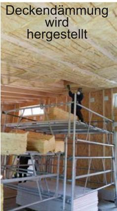
Deckendämmung wird hergestellt
